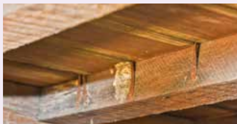
▲床の裏に取り付けられている金具があらかじめ緩められており、床と擦れて音が鳴ります。
