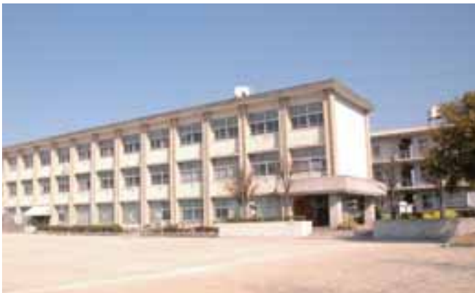
三好中学校の大規模改修工事は、平成20年度から管理棟および普通教室棟の改修工事が始まります
