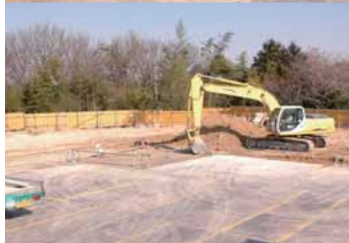
平成21年4月の開園に向けて園舎の建築工事が始まった黒笹保育園(上)と天王保育園(下)
