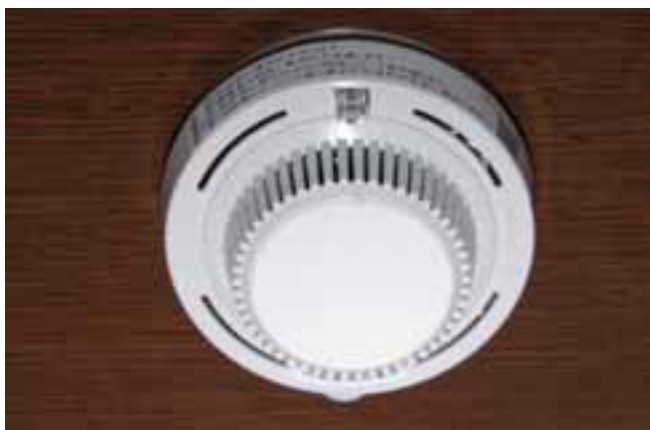
平成20年5月31日までの設置が義務づけられている住宅用火災警報器
