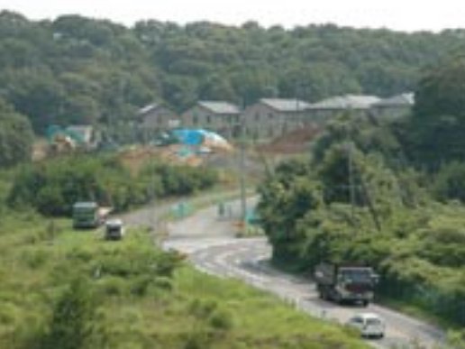
第1期の工事が始まった「やすらぎ霊園」(三好丘旭地内)
