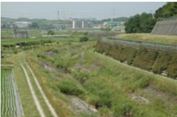
町道福谷線の三好ヶ丘高架橋から見た境川の上流部の様子
